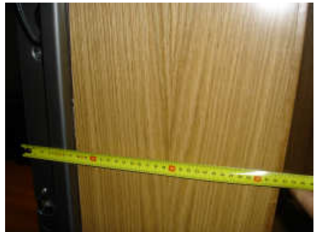
Espessura da parede interior (entre o espaço útil e os espaços comuns)
