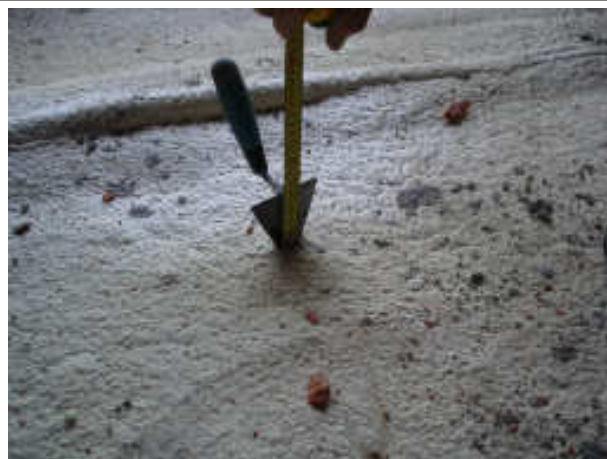
Verificação das espessuras
