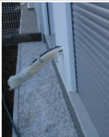
Ligação para colocação da unidade exterior
