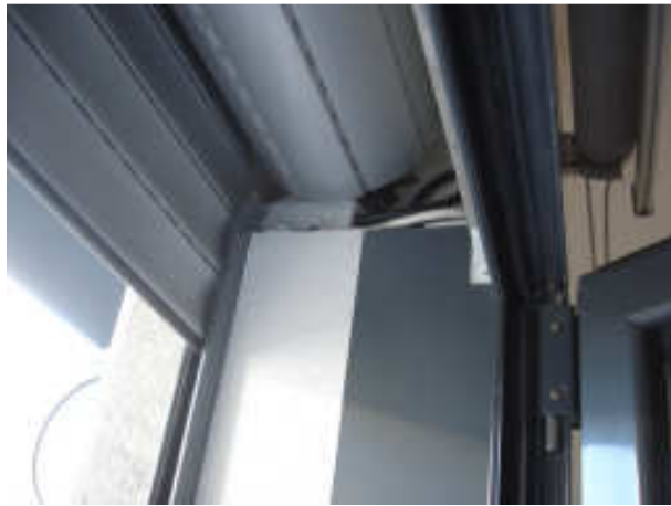
Caixa de estores exterior
