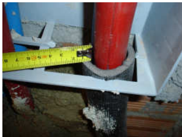
Isolamento térmico da tubagem de água quente
