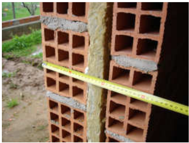
Paredes da fachada
