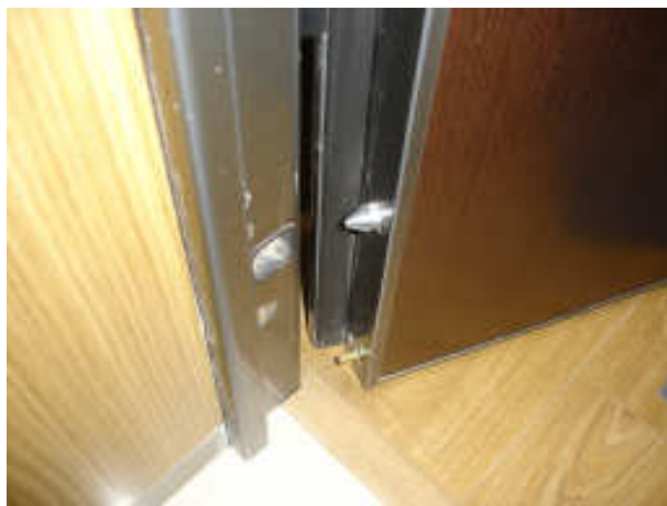
Pormenor da vedação na soleira
