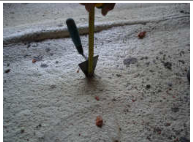
Poliuretano projectado no pavimento
