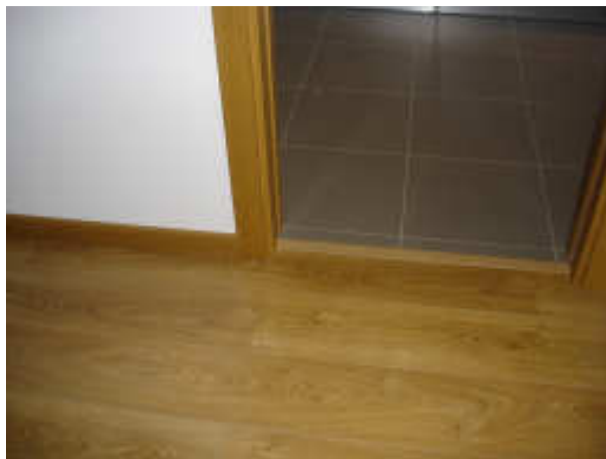
Pavimentos flutuantes nos quartos, salas e corredores, mosaico na cozinha, instalações sanitárias e despensa
