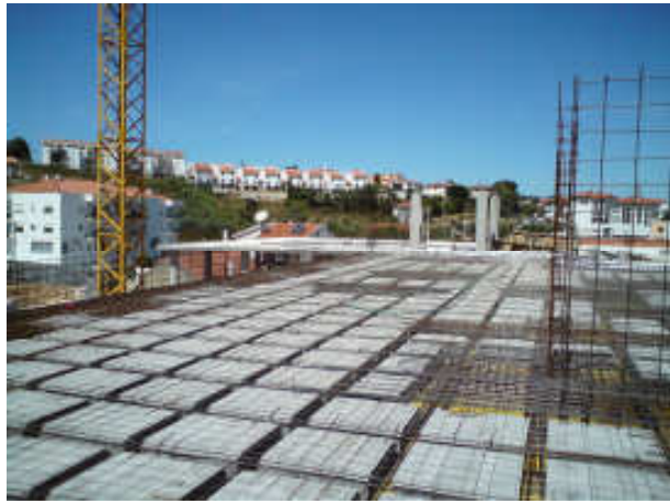
Pavimento em laje fungiforme aligeirada
