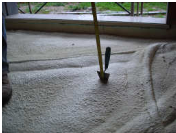
Verificação das espessuras
